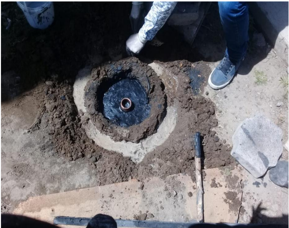
Anexo 14: Instalación del Electrodo Activo-Prototipo.
