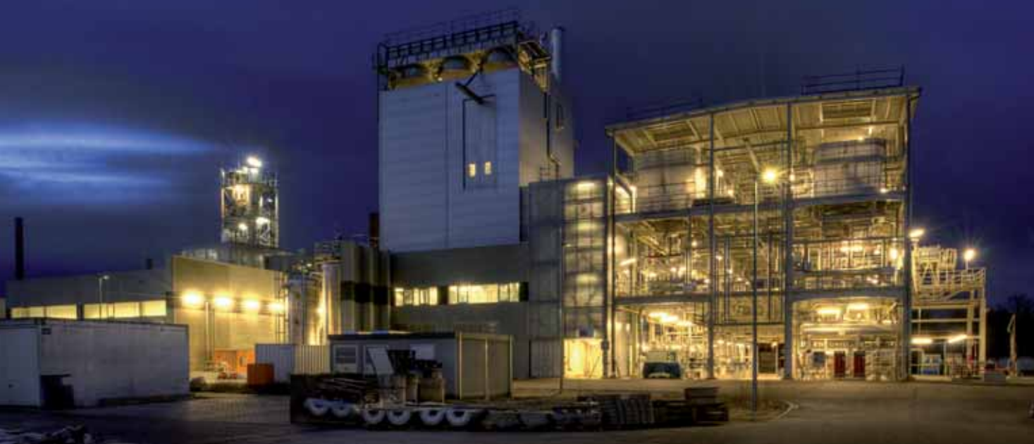
In der bioliq®-Pilotanlage wird Restbiomasse wie Stroh oder Holzabfälle in umweltfreundliche und motorenverträgliche synthetische Kraftstoffe umgewandelt. Foto: KIT
