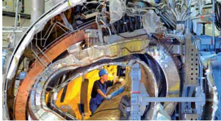
Die Fusionsanlage Wendelstein 7-X wahrend der Montage. Foto: IPP/W. Filser
