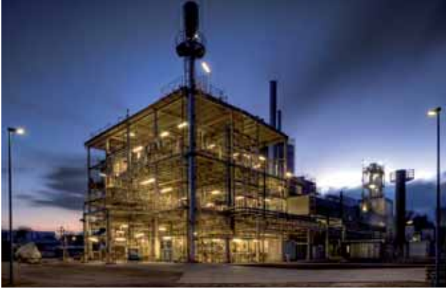
In der Pilotanlage bioliq® wird aus sieben Tonnen Stroh eine Tonne Kraftstoff erzeugt. Foto: KIT
