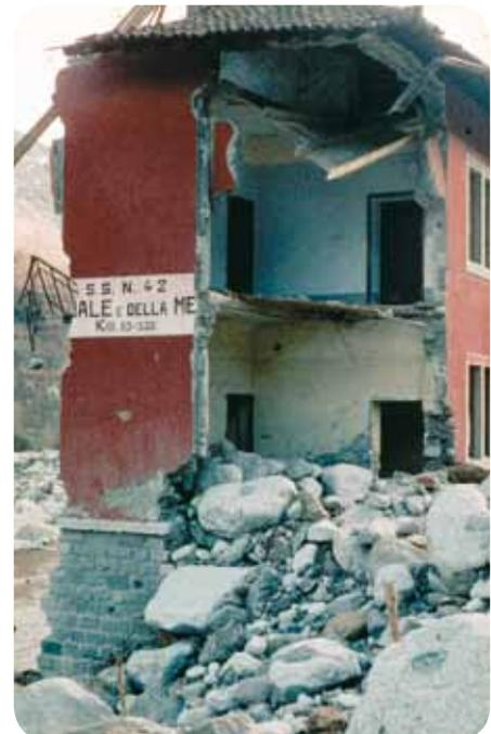
Abb. 3: Naturkatastrophen. Hochwasserschäden an einem Straßenwärterhaus im Adamellogebiet (Südalpen) im Jahr 1961. Das normale Flussbett liegt über drei Meter tiefer.
