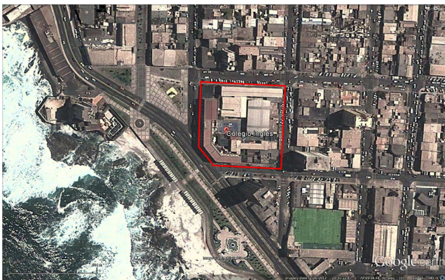
Fig. 3 – Vista satelital del colegio y sus alrededores (Fuente: Google Earth)
