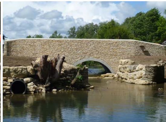
(d) Finished bridge (August 2011)
