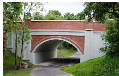
(d) Finished bridge (December 2012)
