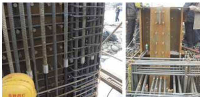
Slika 9. Raspored profiliranog čelika i armature stupa
