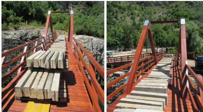
Slika 14. Pokusno opterećenje na mostu
