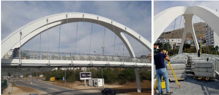
Slika 9. Pokusno opterećenje na mostu
