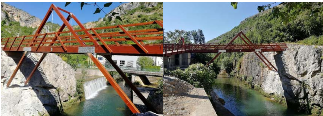
Slika 13. Pješački most na izvoru rijeke Tihaljina, Općina Grude
