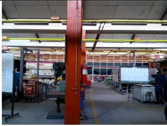
Bengkel yang tidak terdapat jalur evakuasinya
