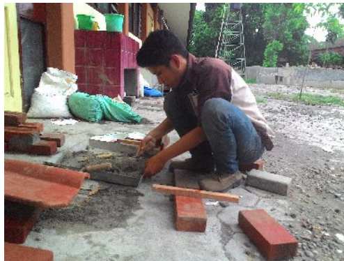
Gambar 39. Proses pembuatan benda uji
