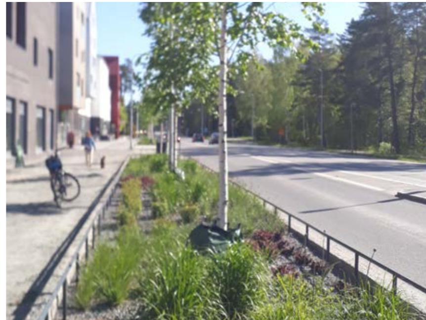
Figur 31. Bilden visar en nyanlagd regnbädd med björkar i bostadsområdet Rosendal i Uppsala.
