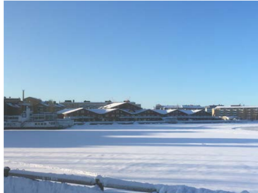
Figur 48. Byggnaden Norrbottensteatern sedd från Namnlösa gatans trottoar.
