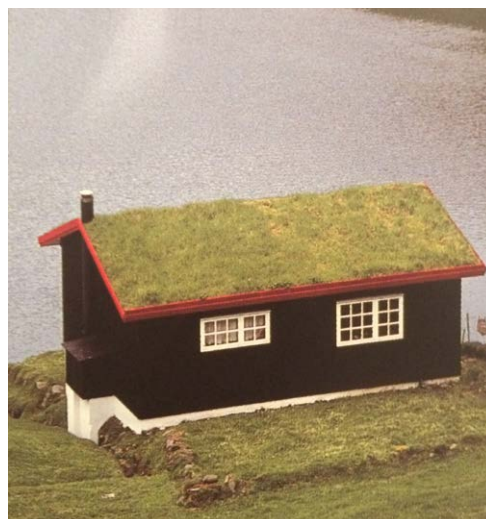
Figur 3. Nordic Green Roof av Douglas De Mers. (CC BY-SA 2.0) Traditionellt skandinaviskt torvtak.
