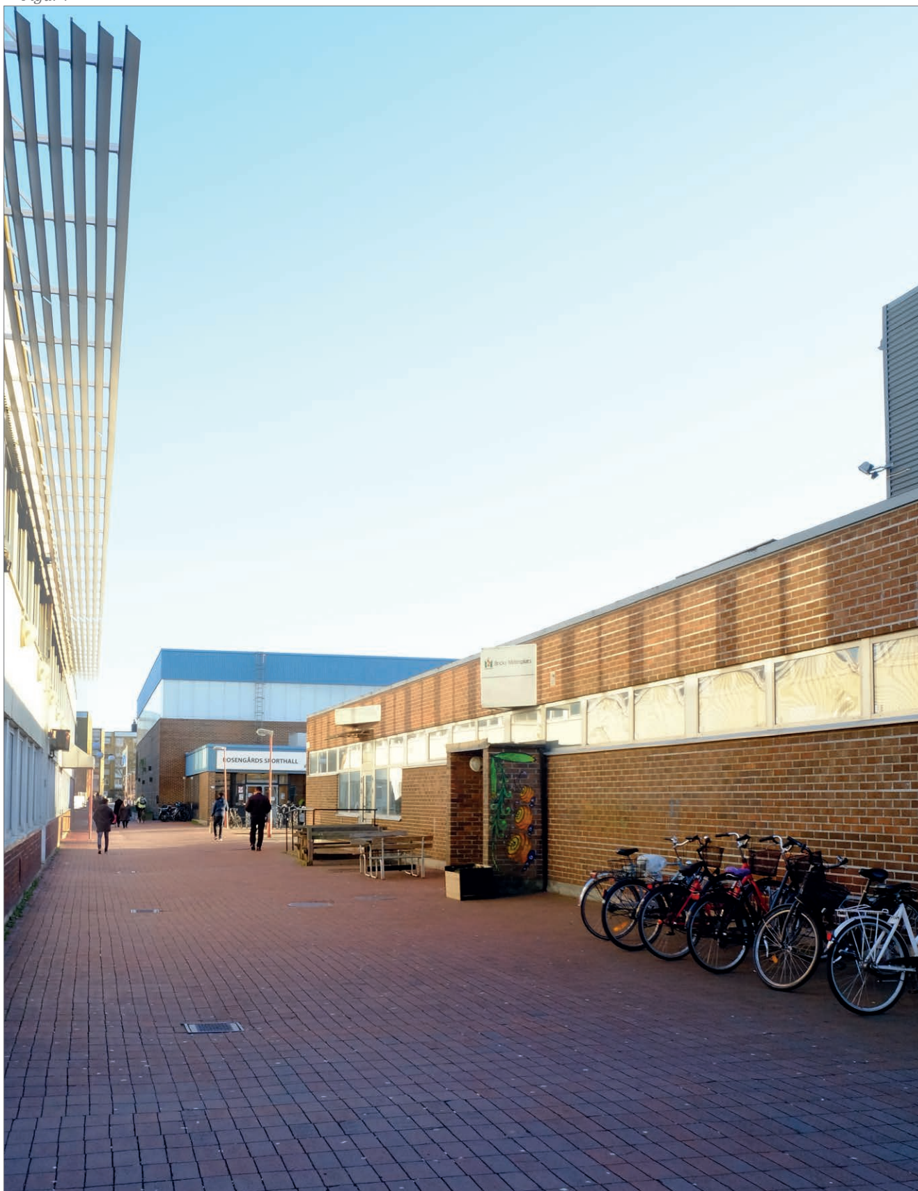
Norra sidan av Tegelhuset.
