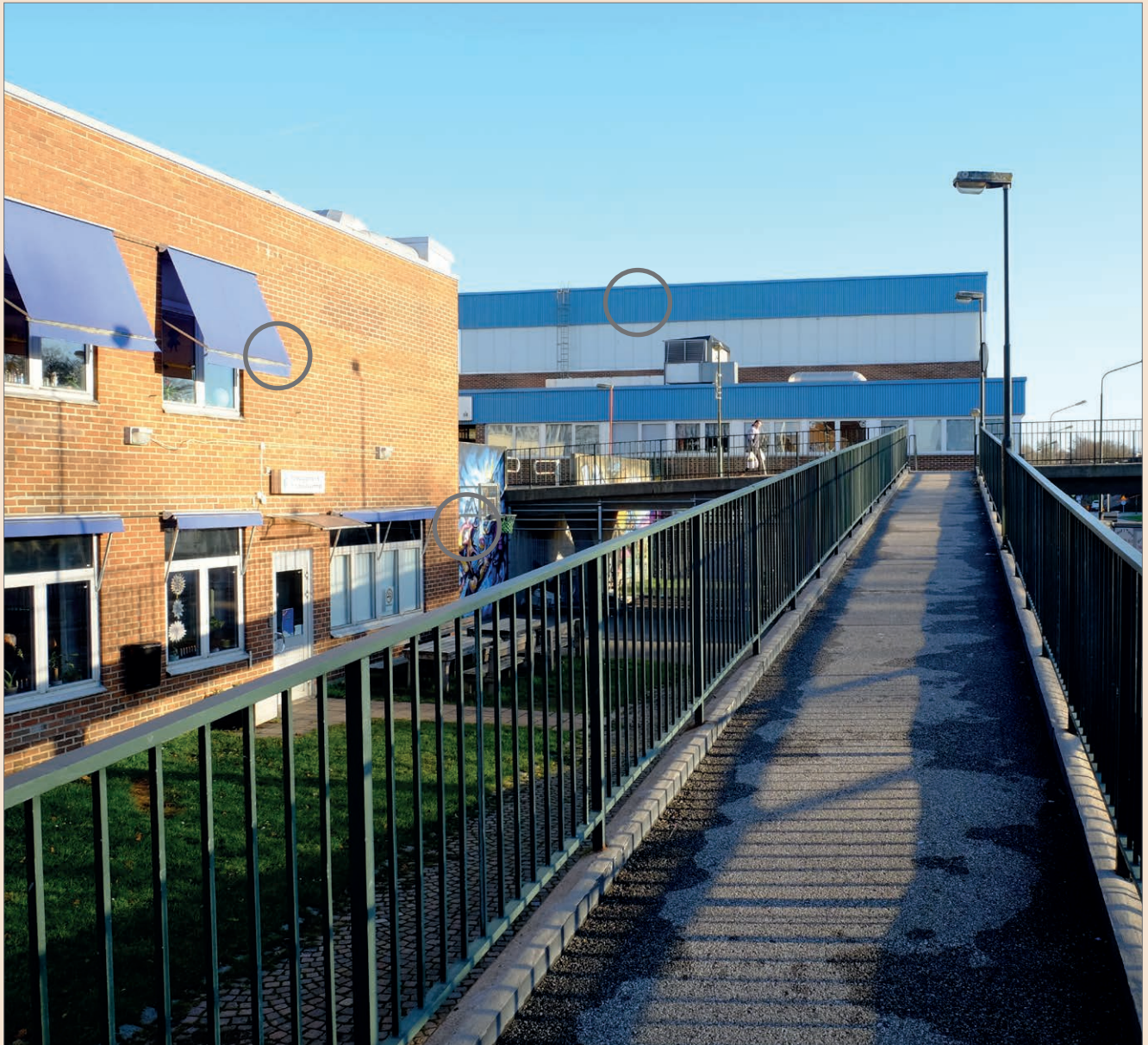
Vy från rampen mot södra bron och sporthallen med fritidsgårdens uteplats längs rampens vänstra sida.
