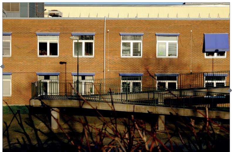
Vy från andra sidan von Rosens väg där rampens höjd blir tydlig mot Tegelhusets södra fasad.
