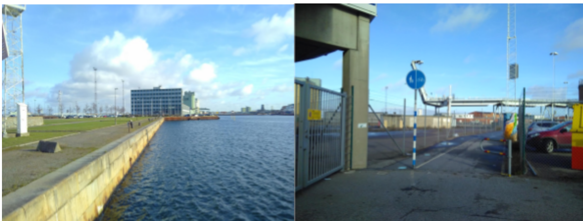
Figur 11. Foto av kajkanten, längst ut på Hullkajen i riktning mot Saltimporten, samt gång- och cykelväg ut mot Hullkajen. Julia Schneider, 2020.
