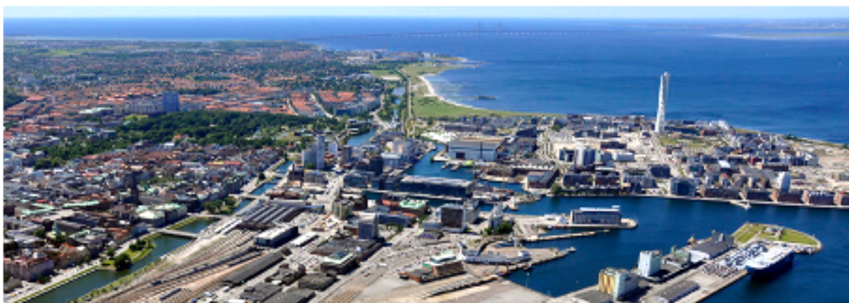
Figur 5. Vy ut mot havet och Öresundsbron, Nyhamnen i förgrunden. Foto: Bojana Lukac/stadsbyggnadskontoret (Malmö stad, 2018b, s. 5).
