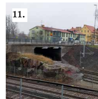
11. Bron vid Bolidenvägen. Här är hela spårområdet nedsänkt och tunnelbanan och tvärbanan separerar sig åt olika håll.
