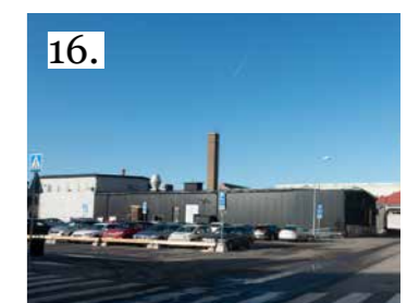
16. Plåt i svart färg
