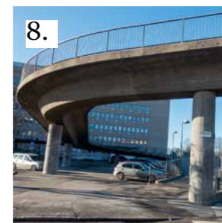
8. Bron mellan Johanneshov och Slakthusområdet är en stor betongstruktur.
