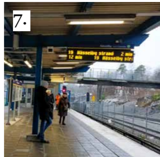
7. På perrongen vid Globens tunnelbana. Perrongen är av betong och har ett plåttak över sig nästintill hela vägen. Pelarna som håller upp taket är av målat blått stål. Längs med perrongen finns träbänkar. Runt några av bänkarna står glasbås.
