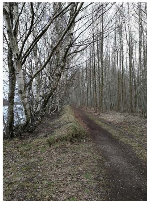
Bild 38. Den befintliga jordvallen som fungerar som översvämningsskydd för området idag.
