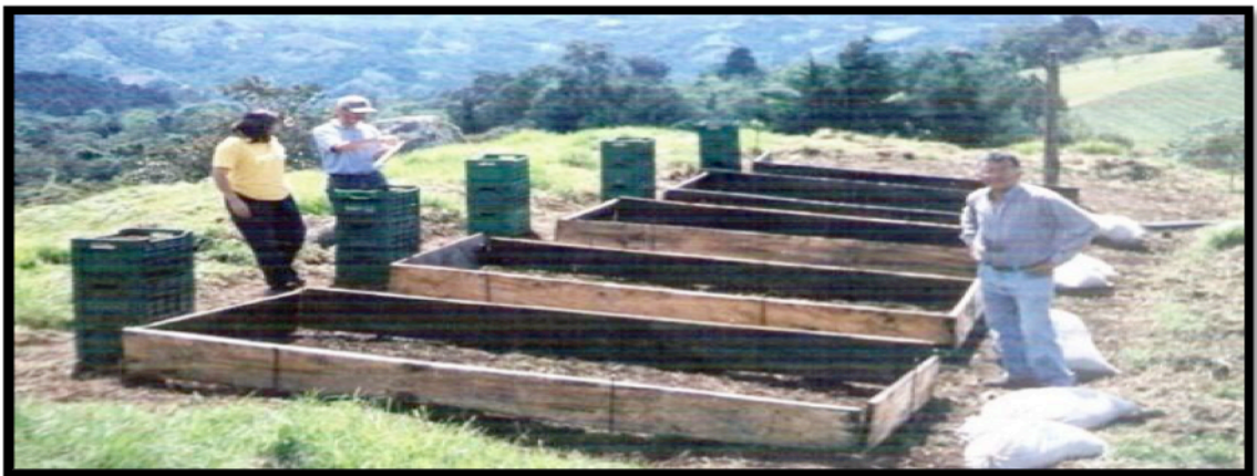
Figura 8. Construcción de los Módulos de Cría
