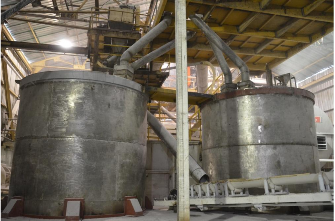
Figura 8. Silos de azúcar
