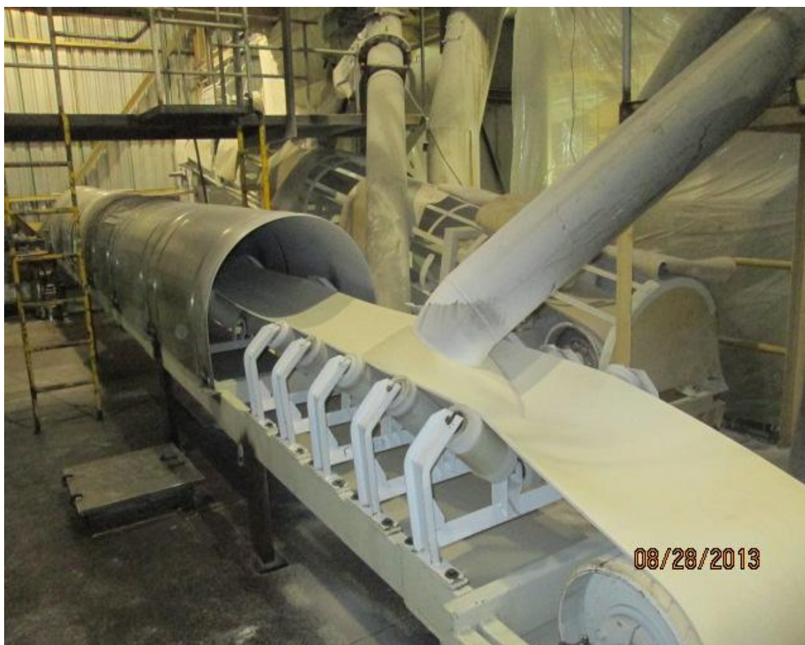
Figura 13. Bandas transportadoras de azúcar obsoletas
