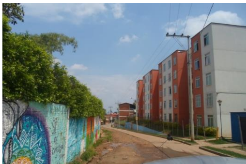
Figura 3. Ingreso por la carrera 80 al conjunto Multifamiliar Alto Piamonte
