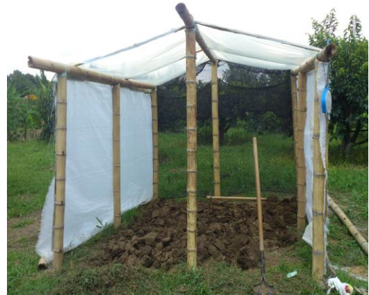
Figura 8. Construcción del invernadero.
