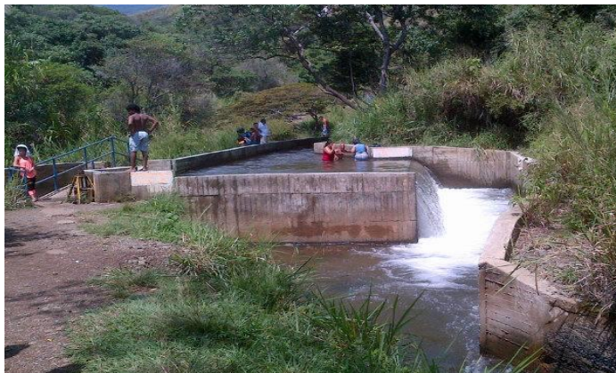
Bocatoma planta 2 la canal río Cali
