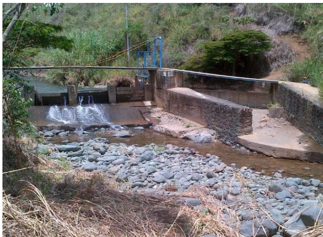
Bocatoma planta 2 río Cali
