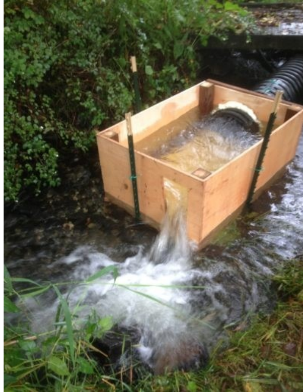
Figure 30. Exemple de passe migratoire au niveau d'un barrage de castor (Beaver Institute- https://www.beaverinstitute.org/ )
