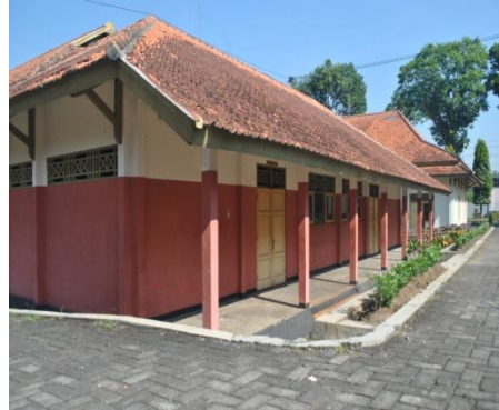
Foto 2. Gedung praktek pengelasan
