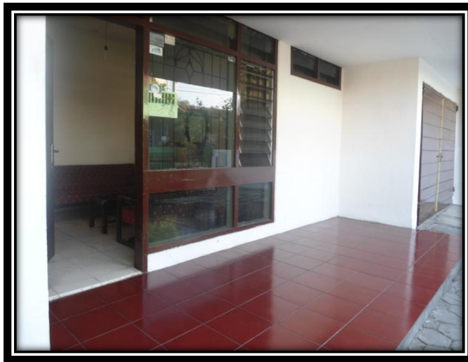
Gambar 26: Tampak Samping Kanan Ruang Teras (Sumber: Dokumentasi Basrullah, 2012)
