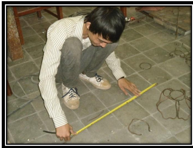
Gambar 69: Pengukuran Besi Beton
