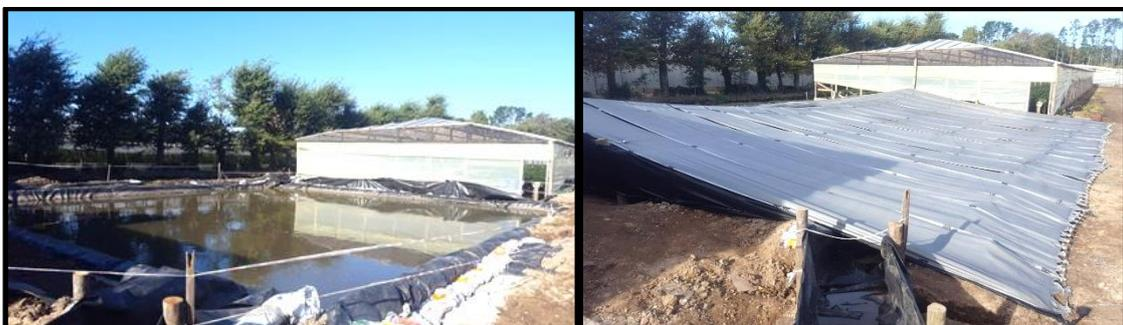
Figura 48. Sistema de captación, conducción y almacenamiento de agua de lluvia para riego.
