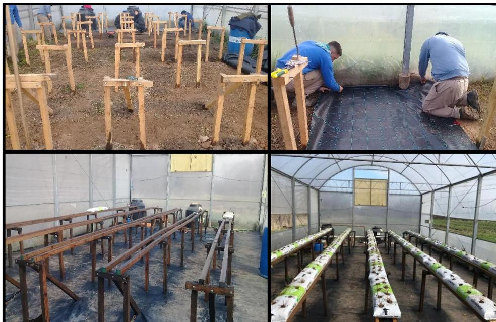
Figura 53. Construcción de la estructura de sostén de los sacos de cultivo y colocación de la malla “cubre suelo”
