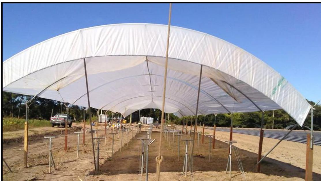
Figura 31. Estructura de sostén de sacos de cultivo de frutilla en sustrato en la parcela experimental “Coronda”
