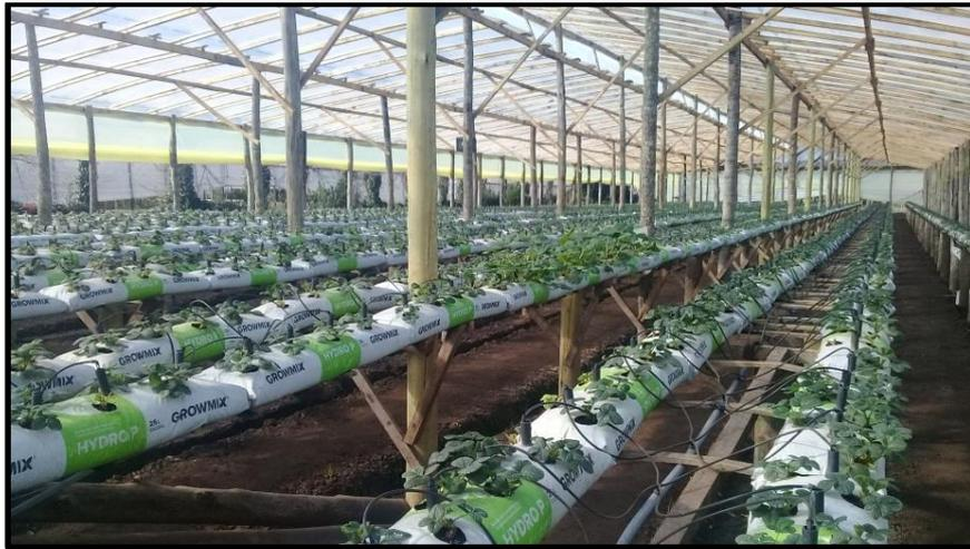
Figura 7. Invernadero tipo capilla simple con cobertura superior fija y laterales móviles. La Polola, Mar del Plata.
