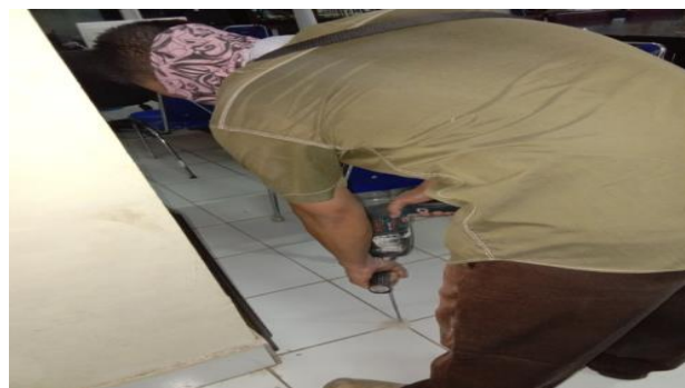
Gambar 1: Pengeboran pondasi perpustakaan Sumber: dokumentasi perpustakaan
