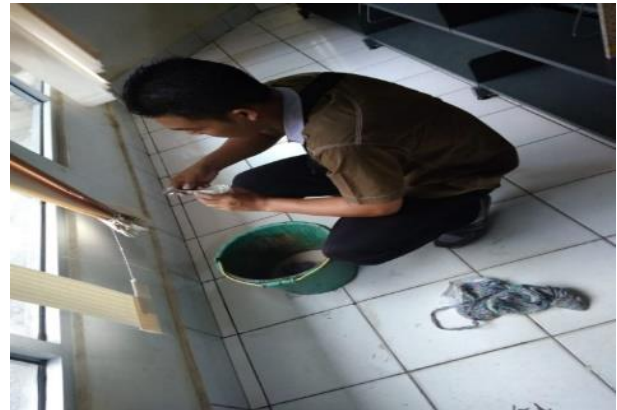
Gambar 4: Penutupan lubang bekas pengeboran Sumber: dokumentasi perpustakaan
