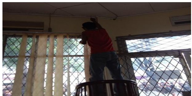
Gambar 5: Penyemprotan lemari dan plafon Sumber: dokumentasi perpustakaan
