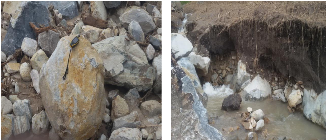
Figura 10- Arrastamento de blocos rochosos e detritos pela água proveniente da encosta da Serra do Moco
