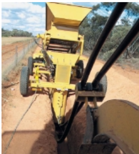
Fig. 9. Tendido del cable subterráneo
