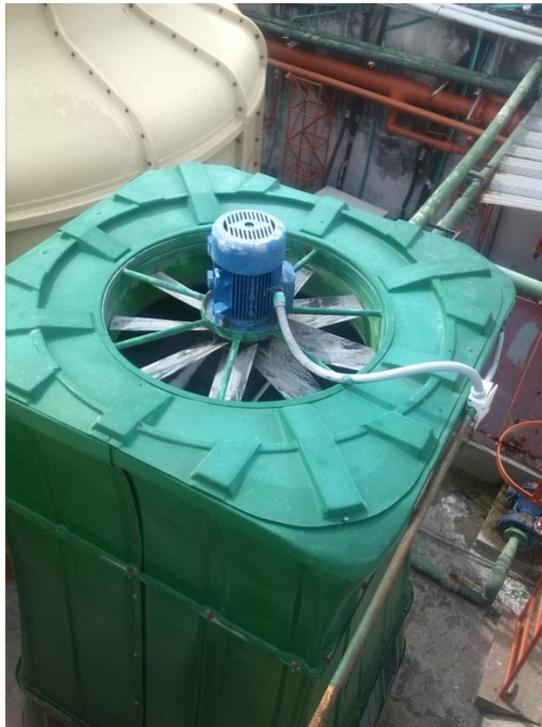
Figura 4. Motorventilador de la torre de enfriamiento
