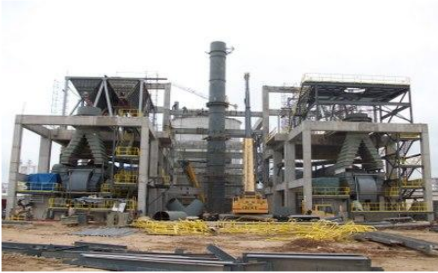
Figura 3. Planta de concreto Argos S. A.
