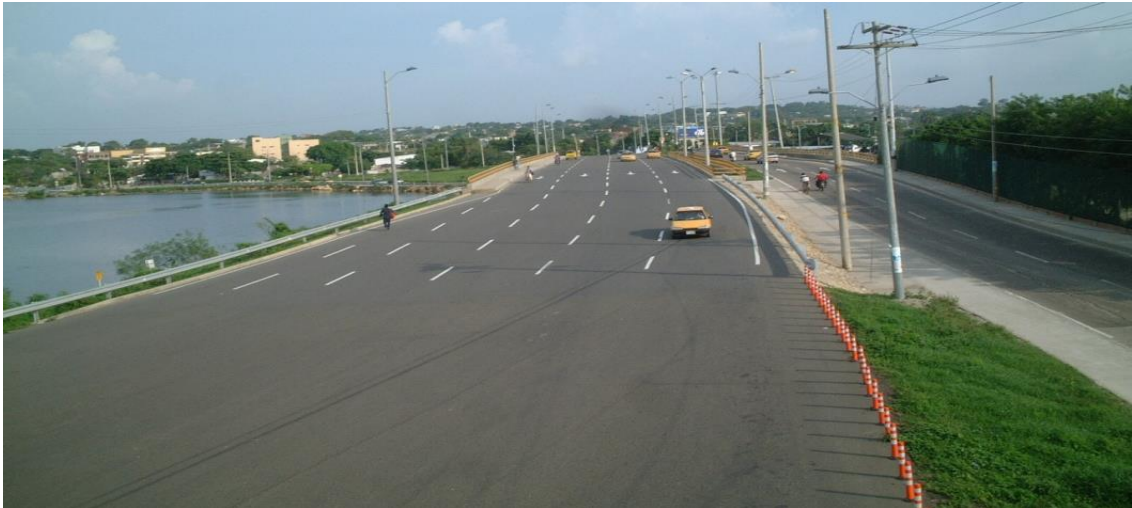
Ilustración 22. Puente de Manga Posterior a Construcción del Corredor de Carga
