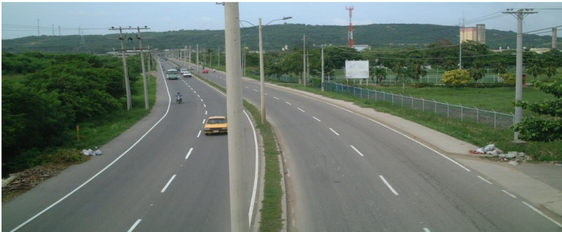
Ilustración 23. Estado de la Vía Mamonal Posterior a Construcción del Corredor de Carga
