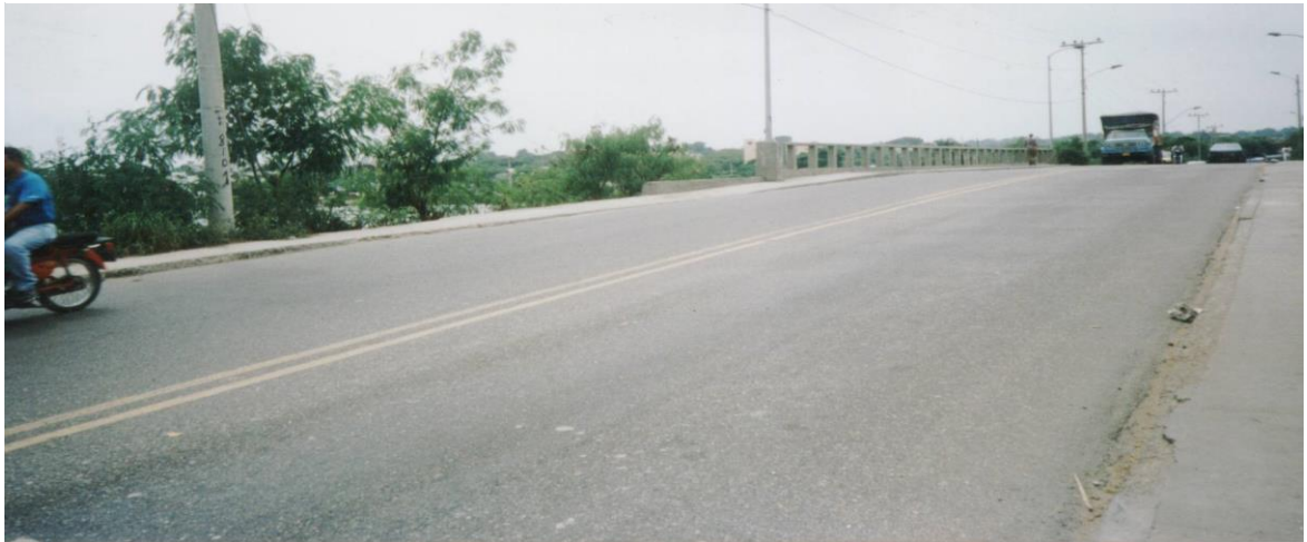
Ilustración 20. Puente de Manga Antes del Corredor de Carga
