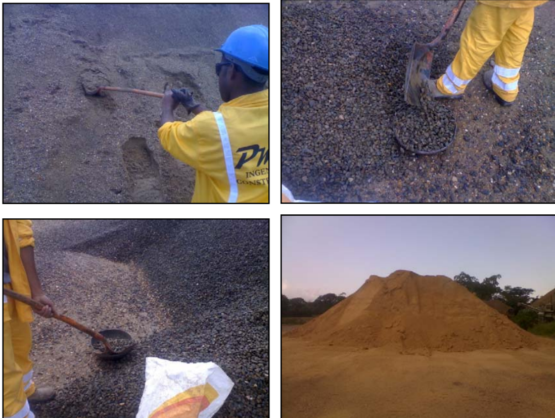
Figura 20. Toma de Muestras para Ensayo Marshall y de Densidades
