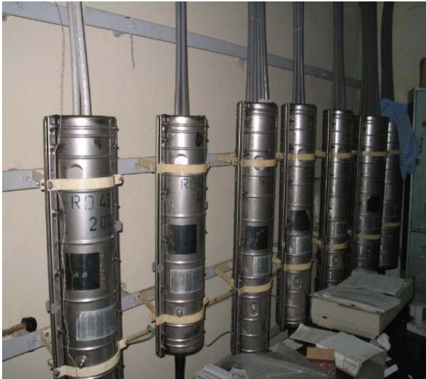
Figura 16. Empalmes troncales o muflas
