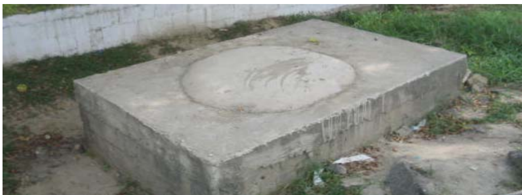
Figura 50. Sellamiento de cámaras
