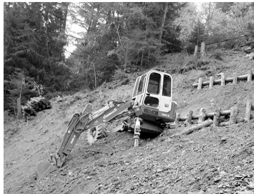
Photo 9 (ci-contre) : Utilisation de pelle-araignée en terrain pentu
