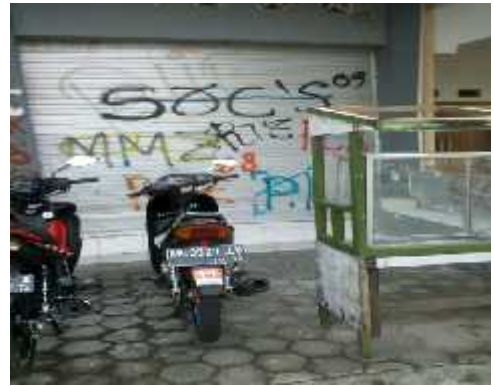
Gambar 14. Vandalisme di rumah warga
