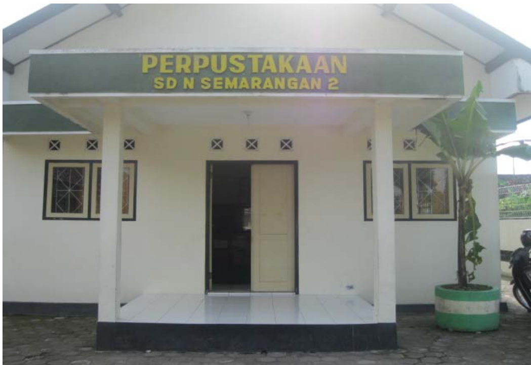
Gedung Perpustakaan SDN Semarangan 2
