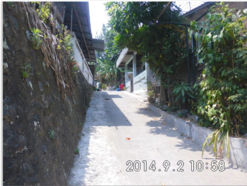
Gambar 6: Jalan menurun menuju kolam renang yang sudah dicor
