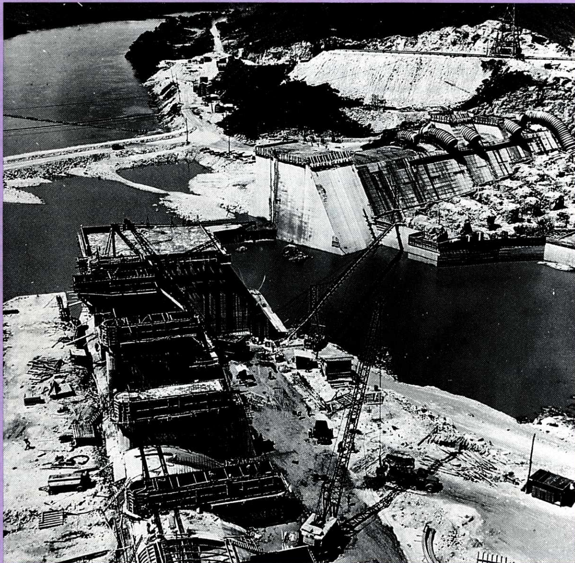
Obras de construção da Usina Hidrelétrica de Peixotos. 1956.
