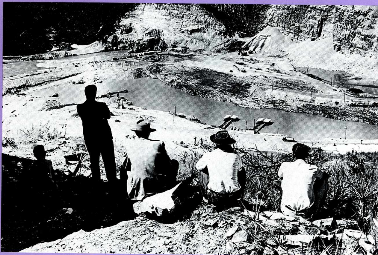
Operação de desvio das águas do rio Grande, onde seria erguida a barragem da Usina Hidrelétrica de Furnas. Minas Gerais, 1959.
