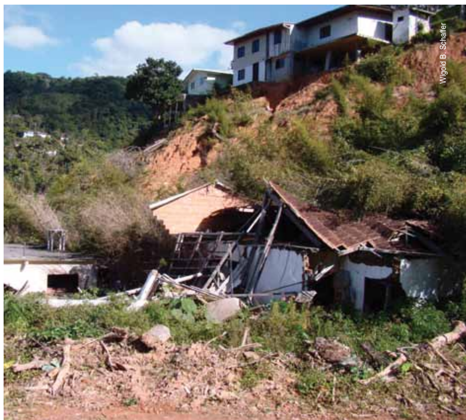
Tirar a vegetação e ocupar as encostas íngremes e topos de morro aumenta os riscos de deslizamentos e enchentes.
