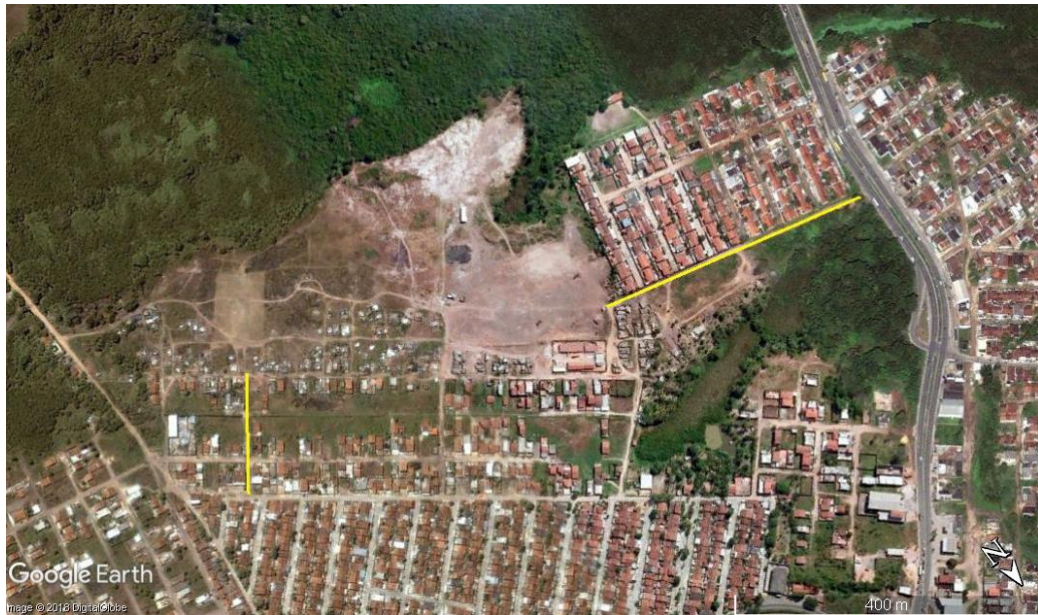
Figura 4 - Vista aérea do conjunto habitacional, mostra das duas vias principais de acesso
