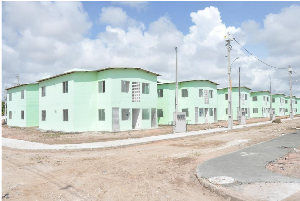
Foto 6 - Vista dos imóveis da segunda etapa do conjunto habitacional
