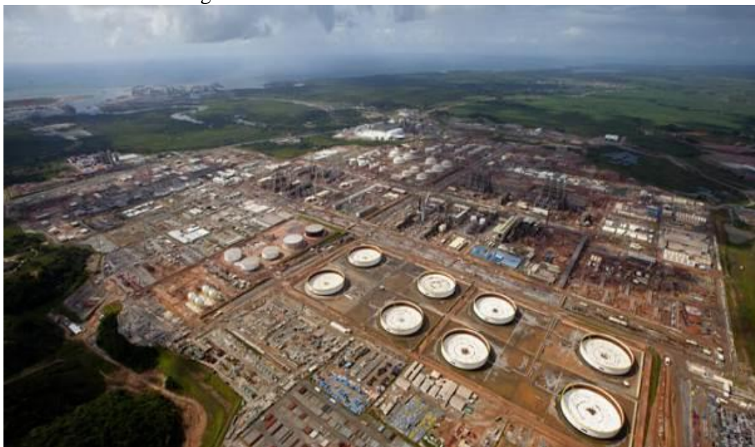
Figura 1. Vista aérea da Refinaria Abreu e Lima
