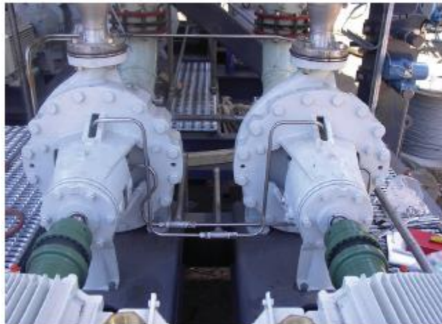
Figura 16. Correcta instalación de bombas centrífugas. Recuperado de http://188.165.118.17:2063/science/article/pii/S0262176209702196
