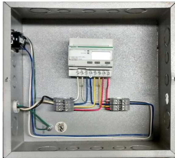
Figura 65. Montaje del medidor en Bancolombia. Fuente: Elaboración propia.
