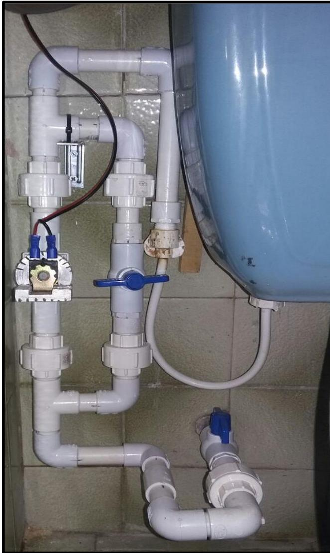
Figura 16. Electroválvula y bypass de entrada agua EPM. Fuente: Autor.
