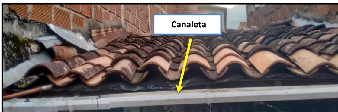
Figura 2. Sistema de captación agua lluvia. Fuente: Autor
