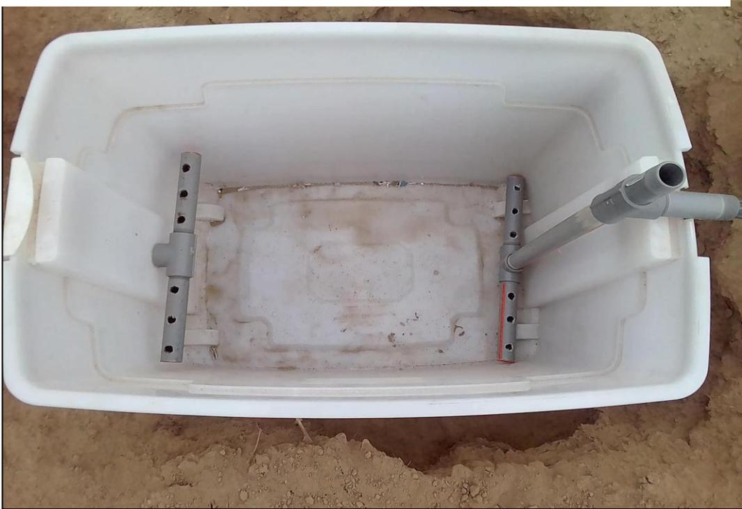
El plástico realiza la función de geomembrana y las tuberías el flujo subsuperficial del agua en forma horizontal, aun sin grava.
