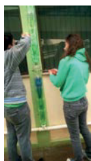
Figuras 3 e 4 (Fixação das tubulações verticais e conexões, com a tubulação horizontal)
