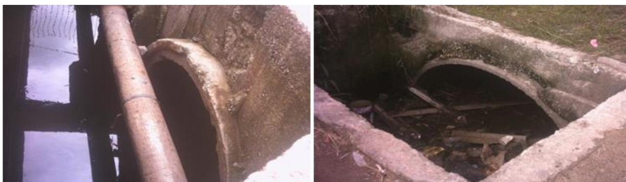
Figura 2 - Construção da EET (Fonte: Francisco Xavier)
