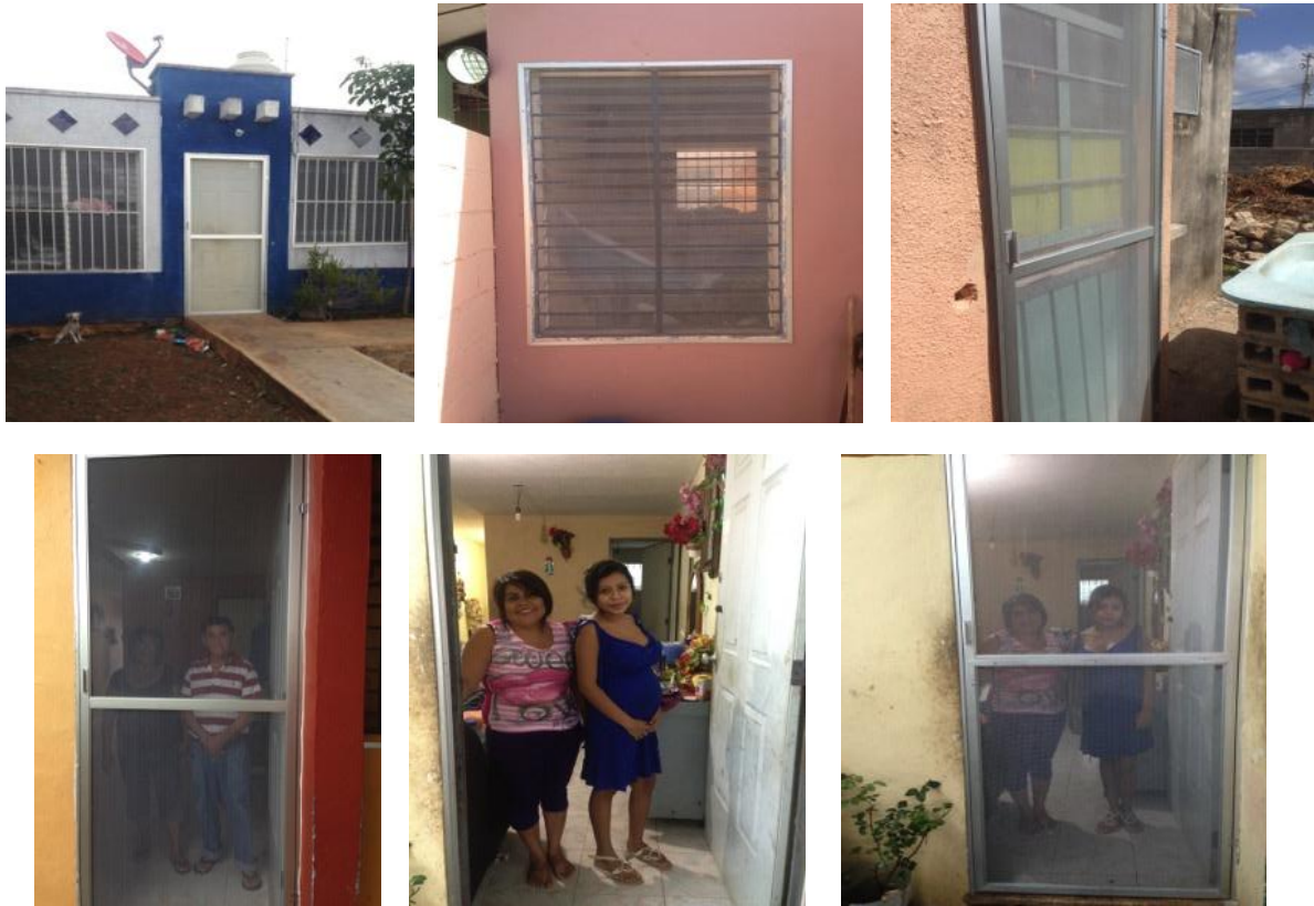
Figura 4.- Instalación de mallas mosquiteras fijas en puertas y ventanas.
