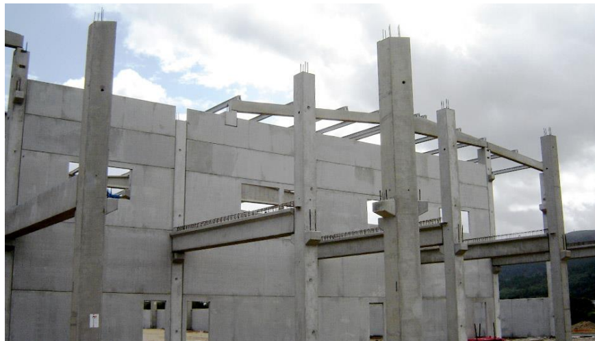
Figura 7-8 Pilares y estructura de hormigón prefabricado.
