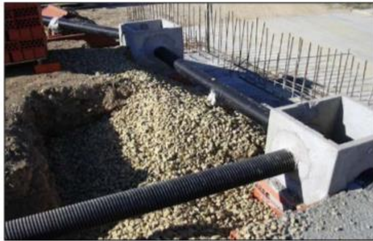
Figura 8-39 Colectores de PVC y arquetas de hormigón.
