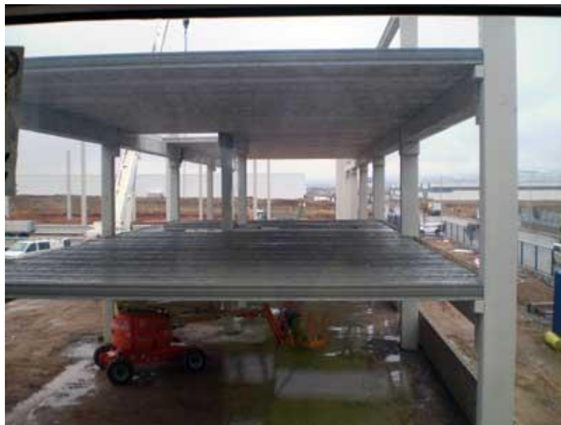
Figura 7-7 Estructura de hormigón prefabricado.
