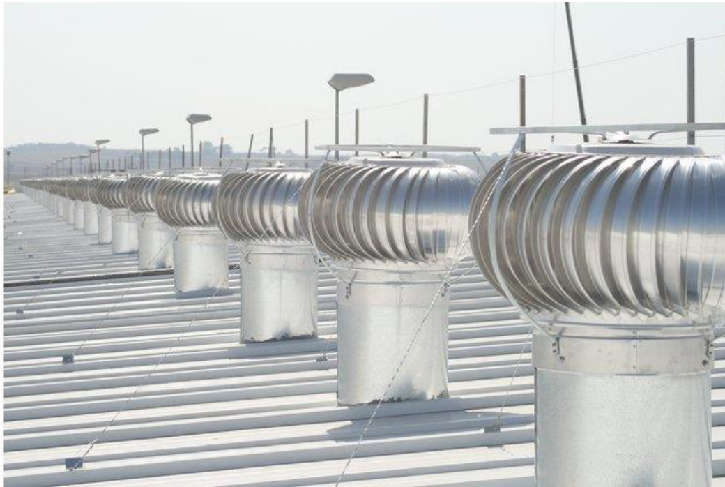
Figura 8-29 Sistema de eccoextractores.
