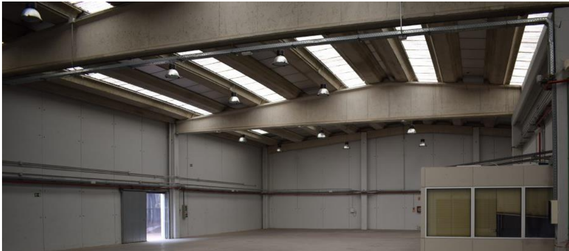
Figura 7-4 Vista inferior de los lucernarios.
