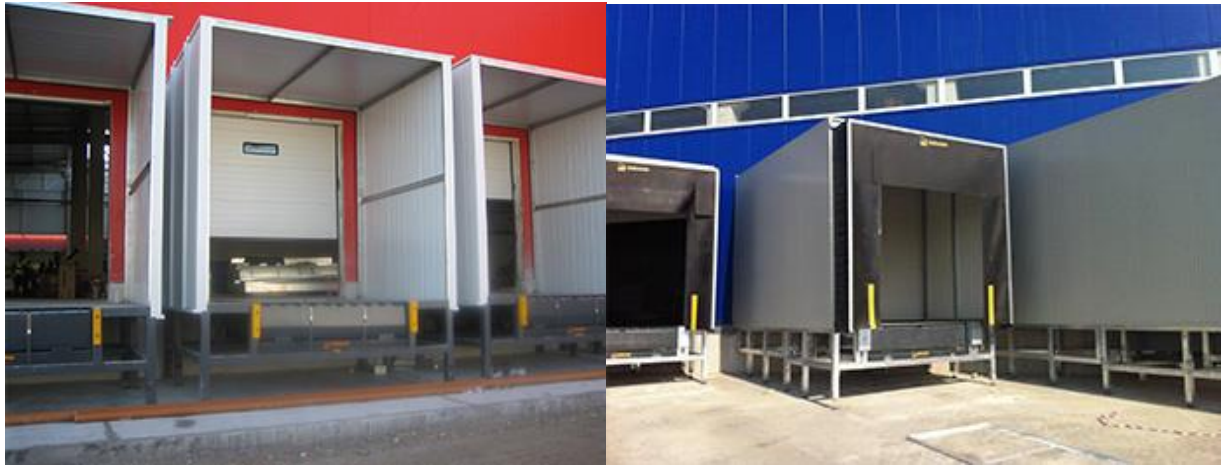
Figura 4-23 Bancadas Metálicas y Túneles Isotérmicos.
