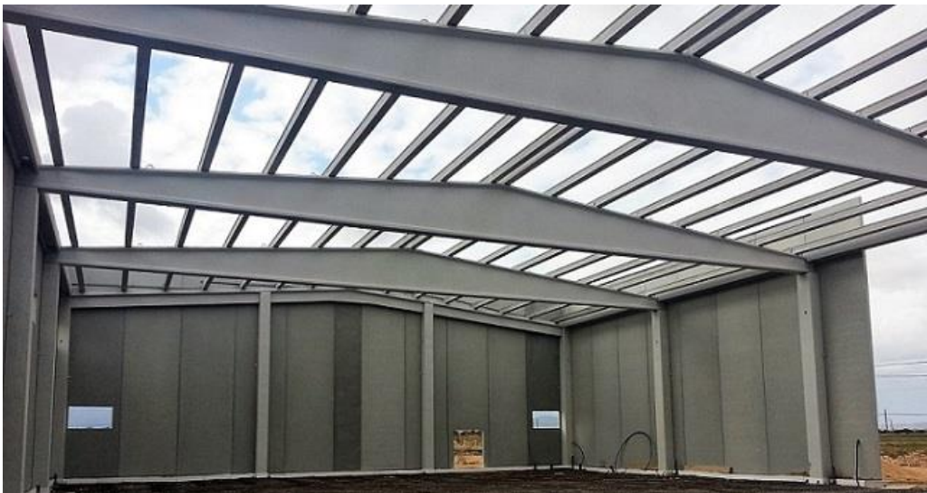
Figura 7-3 Paneles y estructura de nave de hormigón prefabricados.
