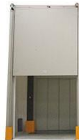
Figura 4-28 Puerta Cortafuegos Corredera (Izquierda) y Puerta cortafuegos Vertical (Derecha).
