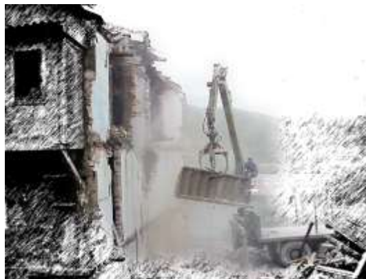
Figura 65. Ilustración de la retirada selectiva de estructuras de madera de un edificio
