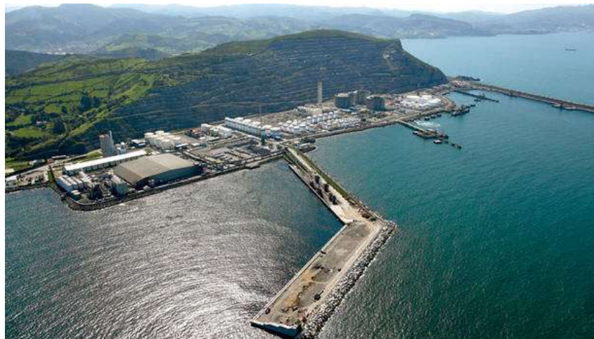
Figura 82: Ampliación del puerto de Bilbao.
