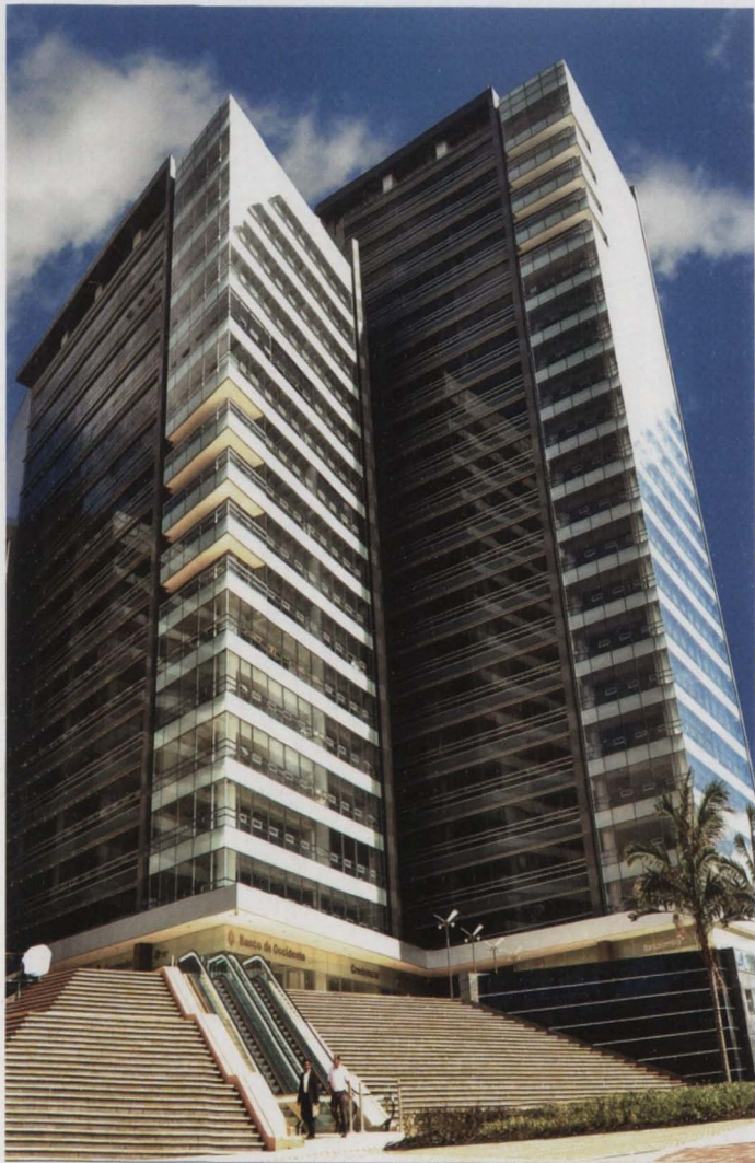
Escalera eléctrica en exterior, parte del Proyecto "Paralelo 108" en Bogotá.
