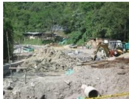
Falla San Jorge
